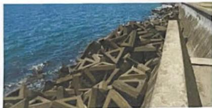
高波を防ぐという防災効果が認められたが、砂浜への砂の補給を遮断し、砂浜の侵食を進めてしまう結果を招いた。
