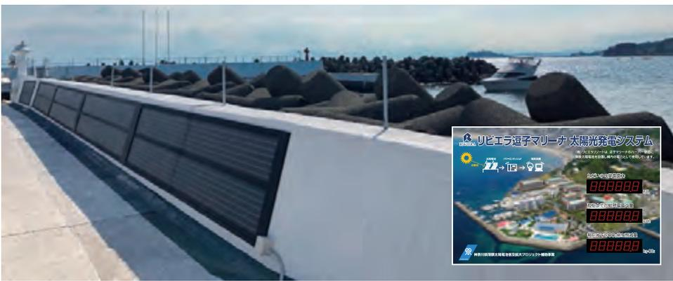
ナの岸壁に薄膜太陽光パネルを設置しました。マリナー岸壁への薄膜太陽光パネル設置は、日本初。
