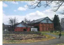
吉野町煉瓦倉庫 外観 ©Naoya Hatakeyama
