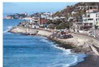
近年の台風の影響もあり、侵食が進む鎌倉海岸・七里ガ浜地区。海沿いに国道134号が建ち、2021年1月
